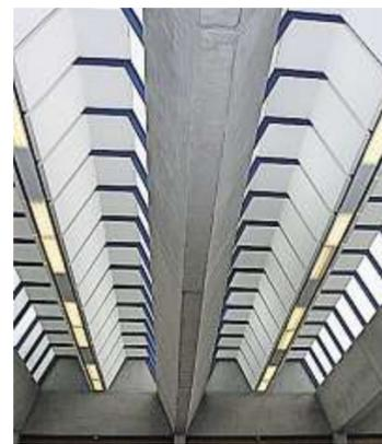
Die Dachkonstruktion mit den V-Trägern im vorderen Teil des Lesesaals
