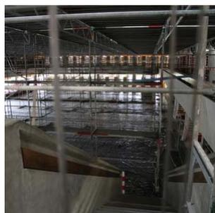
Im nördlichen Teil des Lesesaals PT2 ist ein Gerüst aufgebaut. Es dient dazu, Staub von den Bücherregalen fernzuhalten. Die eigentlichen Bauarbeiten erfolgen auf dem Dach. Foto: Knobloch
