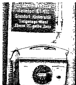
Noch mit Wählscheibe ein Notruftelefon in der Uni-Tiefgarage
