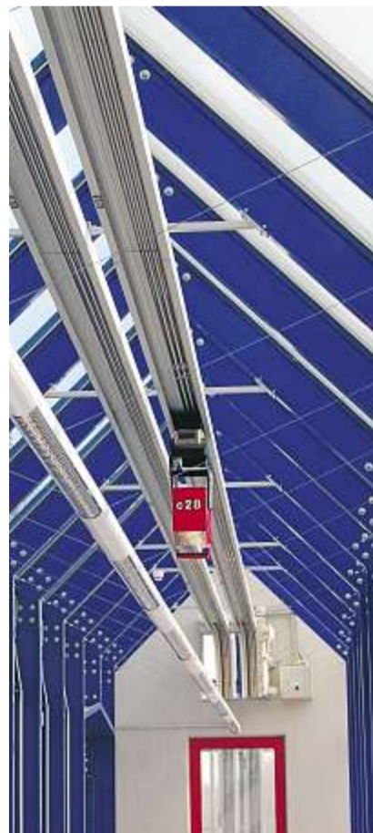
Der Telelift transportiert die Bücher vom Magazin zur Ausleihe.
