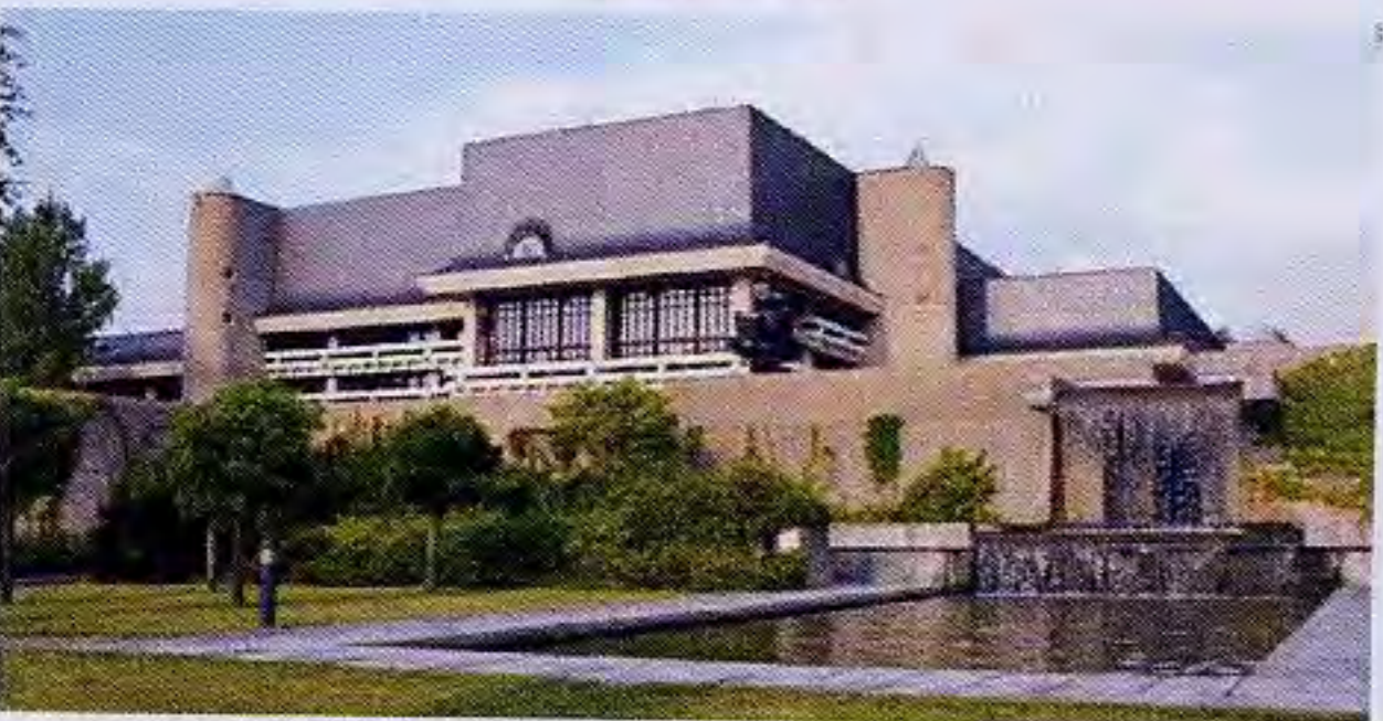
Universitätsbibliothek Würzburg, Überecksicht mit dem „Sockel“ der Tiefgarage
