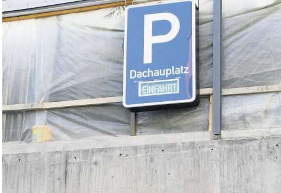
Die Sanierungsarbeiten dauerten länger als geplant. Foto: fb
